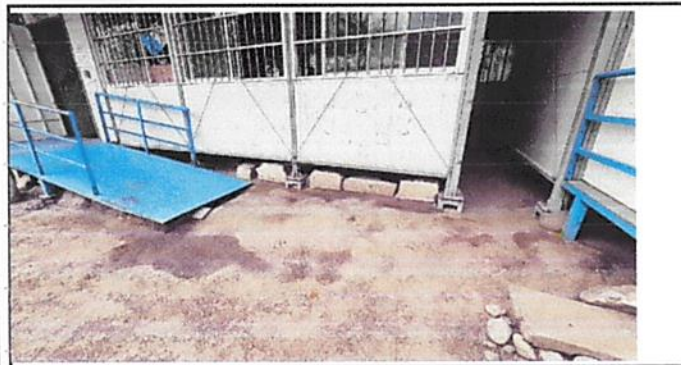
FABRICACION LOSA DE CONCRETO ALISADO DE 0.08 CM
