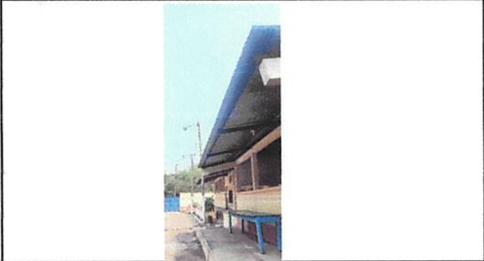
INSTALACION DE CANALES
