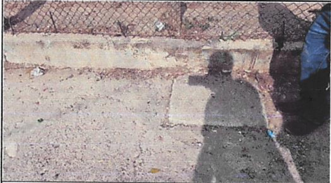
REPARACION DE CAJAS DE REGISTRO
