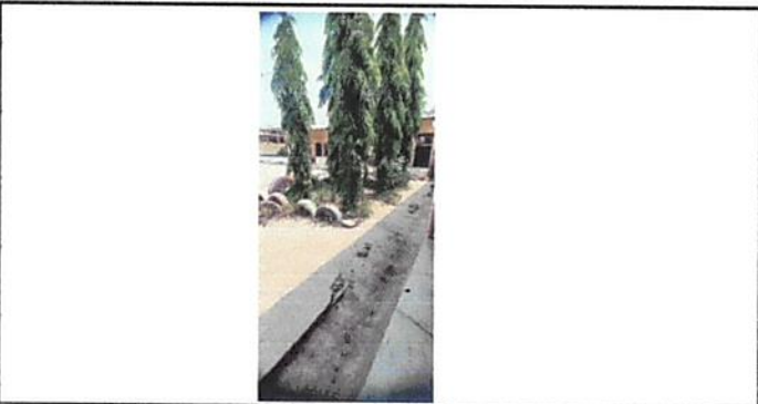
FABRICACION DE BORDILLO Y BARANDA
